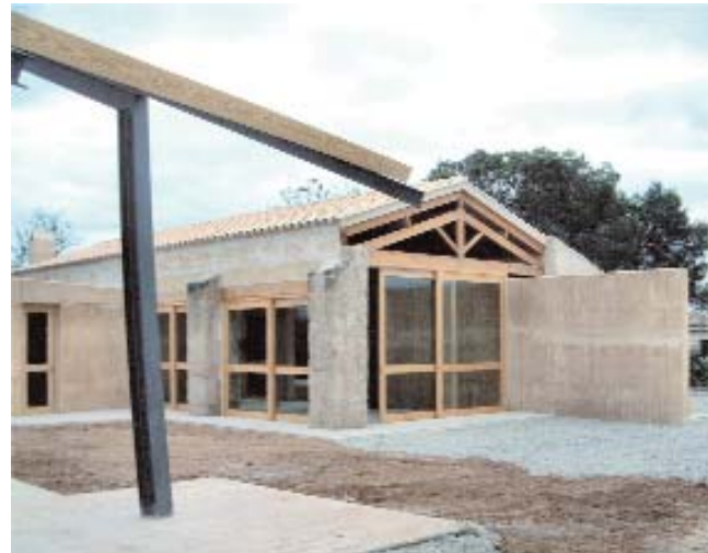
Estat actual de les obres al Centre de Recepció
